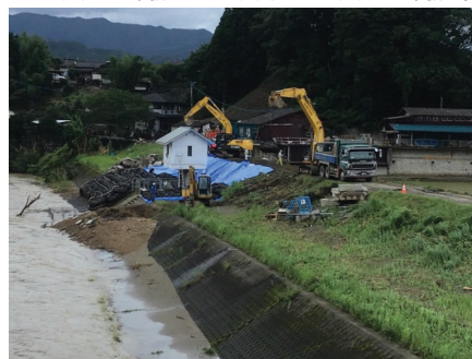
球磨川堤防の復旧（熊本県建設業協会）
