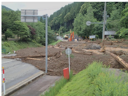
道路の応急復旧（岐阜県建設業協会）
