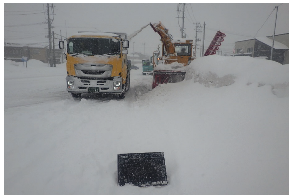
上越市内の除雪作業（新潟県建設業協会）
