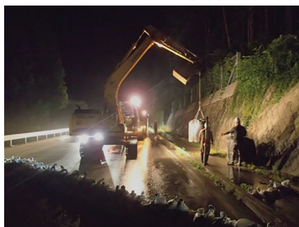
夜間も行われた道路の復旧（岐阜県建設業協会）
