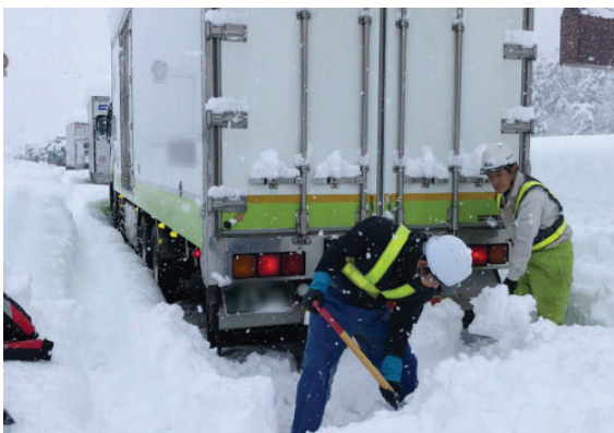
関越自動車道の除雪作業（新潟県建設業協会）
